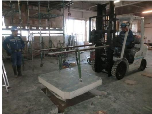
写真⑤ ブロック吊り上げ完了
