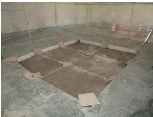
写真⑦ 1階床 全切断・撤去作業完了
