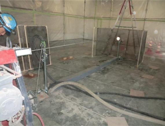
写真① 床板押切切断セット状況全景
