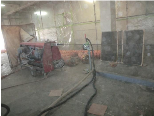
従来集塵方式での現場
