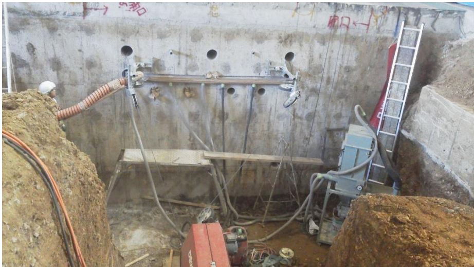
稼働中の工場内において乾式切断を行っている現場写真
