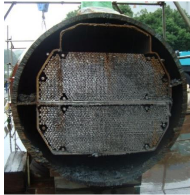
発電所 給水加熱器切断
