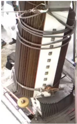
大型変圧器 起立鉄心切断
