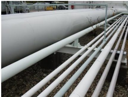
再塗装前配管のケレン・洗浄
