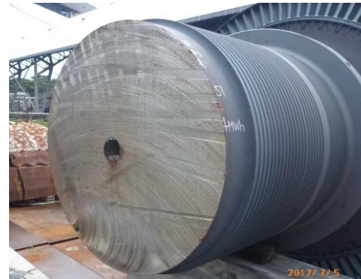
蒸気タービンロータ切断
